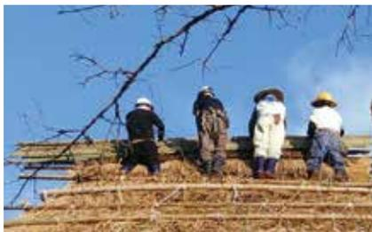
棟を押さえる棟竹をのせる。球磨地方では半分に割った竹を13本並べて編んだものが多い。棟の頂点にくる竹は「天の竹」と呼ばれる
