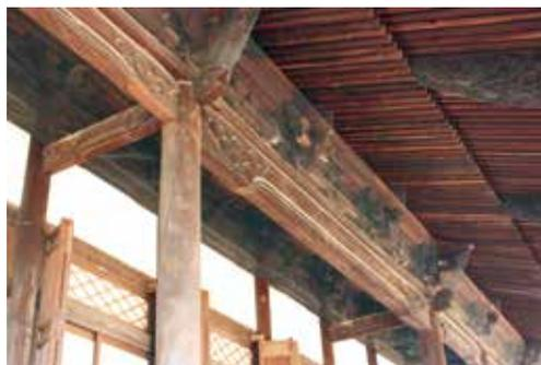
写真⑦ 虹梁の上の水平な部材が台輪。写真右に写る彫物が手挟たばさみ
