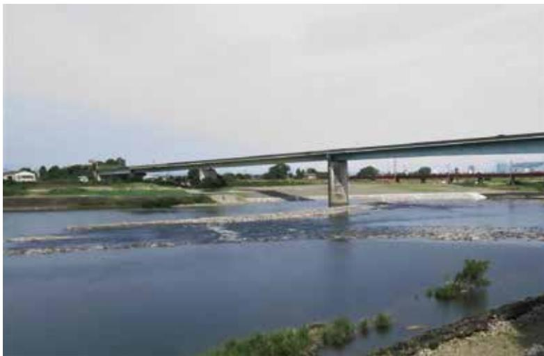
遙拝堰の下にできた八の字堰風構造物
