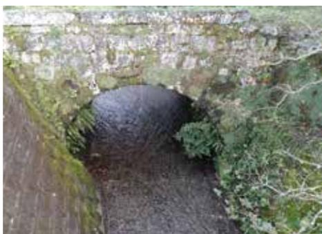
あがたばし 県橋(美里町石野字県)。雄亀滝橋を通じて流れた水は同橋下流200mほど下流の県地区に流れ出していた。県橋は同地区にある。同地区では稲作がおこなわれて訪問したとき(昨年10月7日)、刈り取れた稲が掛け干しされていた。橋長5.5m。橋幅1.8m。径間3.6m。弘化2年(1845年)、作者不明(ただし、種山石工であることは確実である)。
