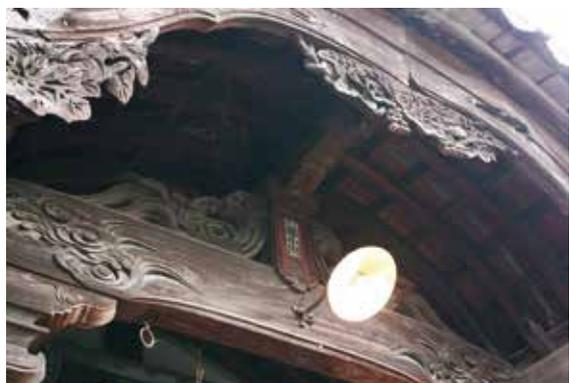
写真④ 大唐破風。カーブの上部の彫刻が兎毛通。カーブの下部の彫刻が降懸魚。写真中央が大瓶束笈型という形式の中備
