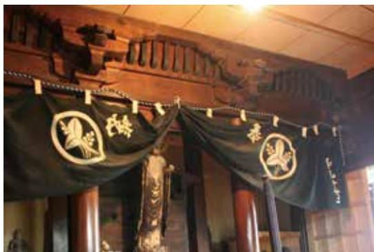
写真⑦ 丸柱の上の出組。黒い帯が連続しているものを蛇腹支輪とよぶ
