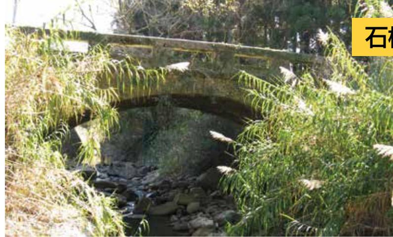
「境橋」全景 (川下側)。明治16年(1883)築造。橋長13.5m、橋幅4.9m。単眼アーチ橋。石工・不明。
