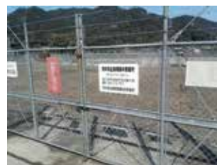
藤本発電所跡
